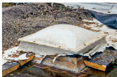
Fermetures apparentes en lés de matière synthétique perforées par la grêle.
