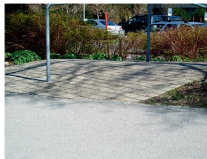
Rampe pour franchir une digue périphérique en terre.
