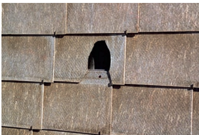
Perforation de plaques en fibres-ciment.
