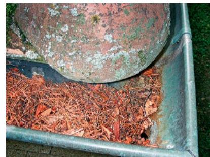
Le contrôle et le nettoyage périodiques des gouttières permettent d'éviter que les tuyaux de descente ne soient obstrués par des feuilles et des branches.
