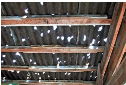
Perforation de plaques profilées en fibres-ciment.
