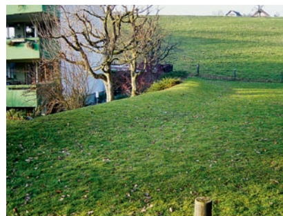
Digue en terre aménagée en limite de parcelle et bien intégrée dans le paysage.
