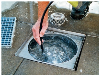
Nettoyage sous haute pression d'un dispositif d'évacuation des eaux obstrué.
