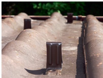
Exemple de crochets arrête-neige.
