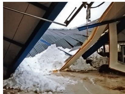
Exemples d'effondrements de toits de halles reposant sur des poutres en bois et en acier.
