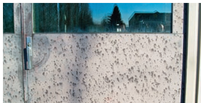
La taille des bosses affectant la tôle dépend de la nature et de l'épaisseur
