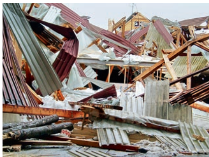
Exemples d'effondrements de toits de halles reposant sur des poutres en bois et en acier.
