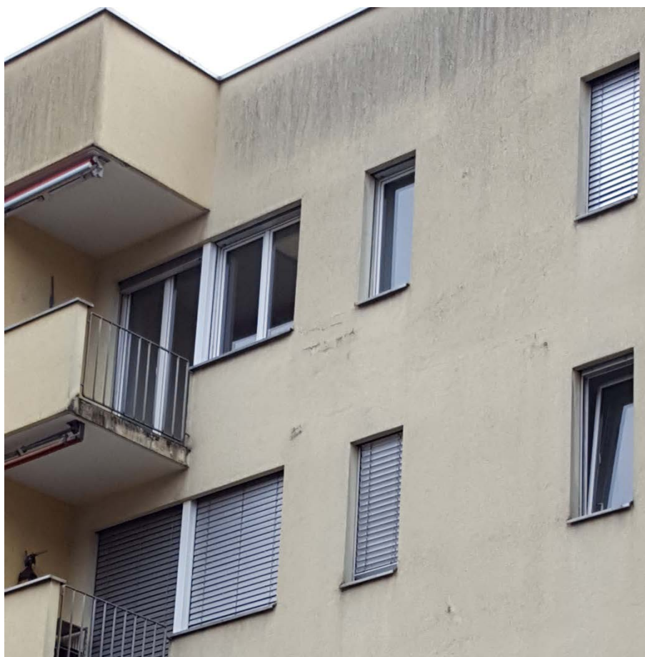
Figure 29 : Coloration de la couche de peinture due à une infestation d'algues, exemple d'un bâtiment à Zurich.
