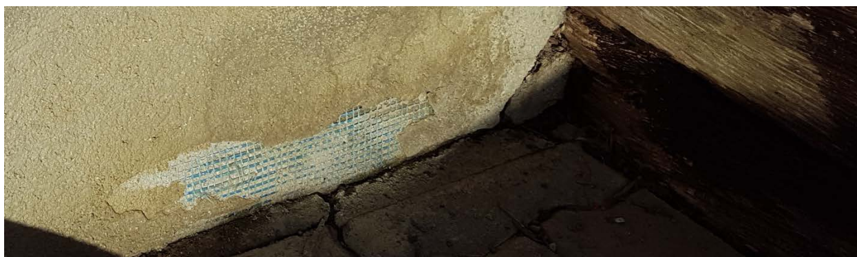
Figure 32 : Éclatement dans la couche de finition dû à des dommages mécaniques (probablement causés par l'impact de raquettes ou d'une pelle à neige) combinés à des cycles de gel/dégel, exemple d'un bâtiment à Grindelwald.
