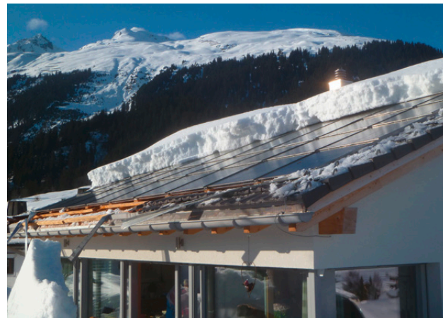
Illustration 27. À gauche : la neige accumulée (pression de la neige) a enfoncé la structure du toit de l'abri à voiture ; à droite : en glissant (avalanche de toit), la neige a endommagé des parties du toit et de l'installation photovoltaïque (photos : GVG).
