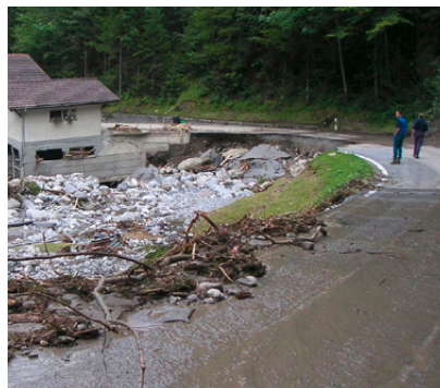
Illustration 18. À gauche : inondation statique très étendue ; au centre : bâtiment et rue endommagés par l'érosion des berges ; à droite : dépôts de laves torrentielles (photos du centre et de droite : geo7 AG).
