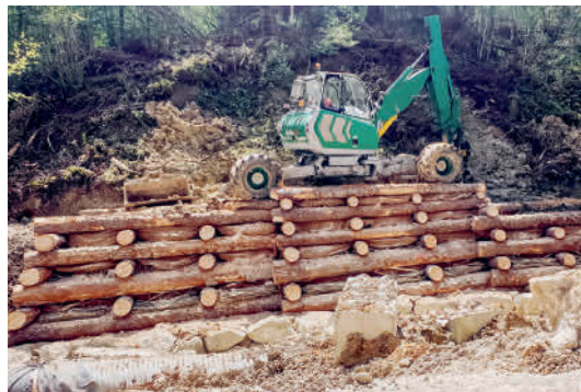
Figur 74 (rechts) Dreibeinböcke und Stein- schlagschutzwand aus Holz sichern Infrastruktur.
