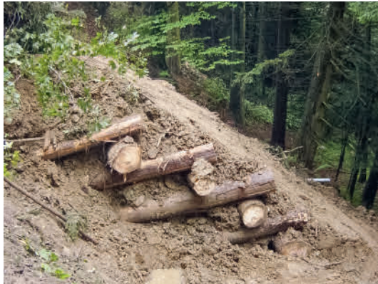
Figur 71 (links) Eine vollständige Eindeckung kann die Nutzungsdauer auch von weniger dauerhaften Holzarten wie Fichte deutlich erhöhen.
