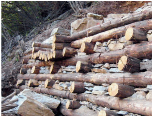
Figur 25 (links) Ausfachung mit Steinen als Füllmaterial.
