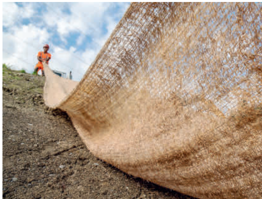
Figur 8 Erosionsschutz mit Böschungsmatten aus Holzwolle.
