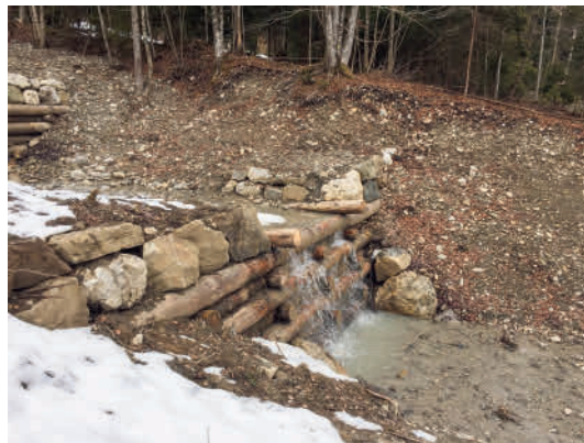
Figur 38 Links: Holzkastensperre mit Flügeln aus Wasserbausteinen und Ausfachungen mit Rundhölzern. Rechts: Vorfeldsicherung mit Wasserbausteinen.
