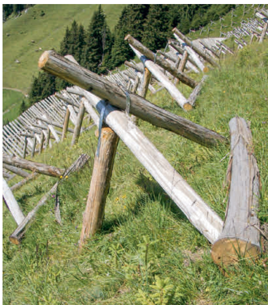
Figur 55 Dreibeinböcke mit bergseitigem Querholz schützen Jungpflanzen vor Schneegleiten und -kriechen.
