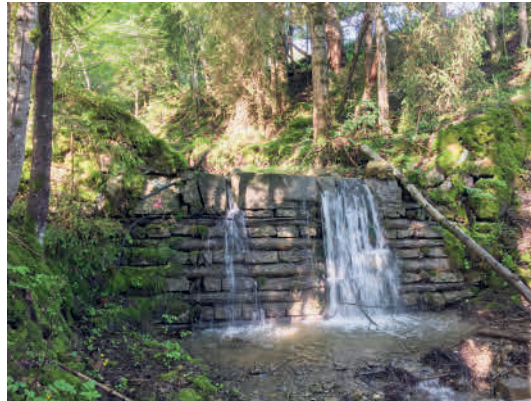
Figur 67 Sperrbauwerk im Schaferabach in der Gemeinde Plaffeien FR. Einige Sperren im Schaferabach sind nachweislich zwischen 1940 und 1945 erbaut worden und bestehen somit seit über 75 Jahren unverändert.
