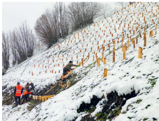
Figur 53 Verpfählung zum Schutz einer Erschliessungsstrasse vor Schneegleiten; wichtig ist das Einrammverhältnis der Pfähle von 2:1 im/über dem Boden.
