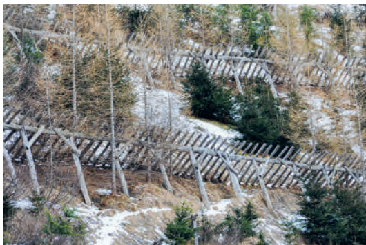
Figur 51 Holzschneerechen Typ SLF in Kombination mit Aufforstungen zum Schutz einer Verkehrsachse.
