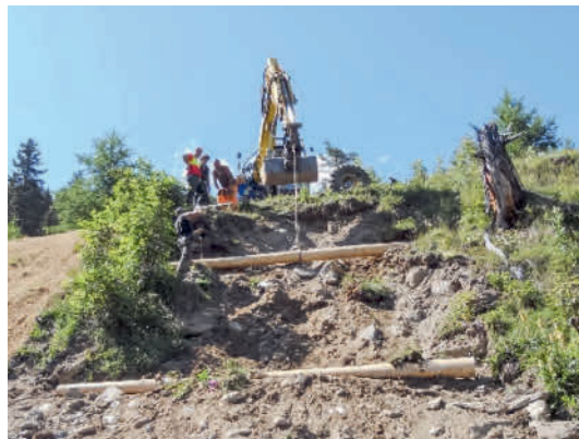
Figur 19 (links) Bau von rückverankerten Holzschwellen zur Stabilisierung einer Böschung.
