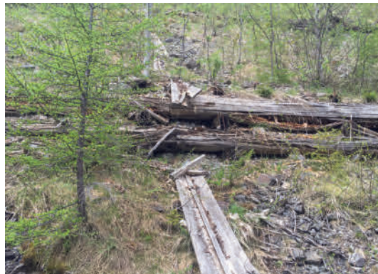
Figur 9 (links) Terrasse aus einwandigen, zersetzten Holzkästen kombiniert mit Wasserableitungsrinne in Arieschbach GR.
