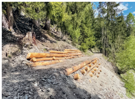
Figur 28 Böschungsstabilisierung eines Waldweges.
