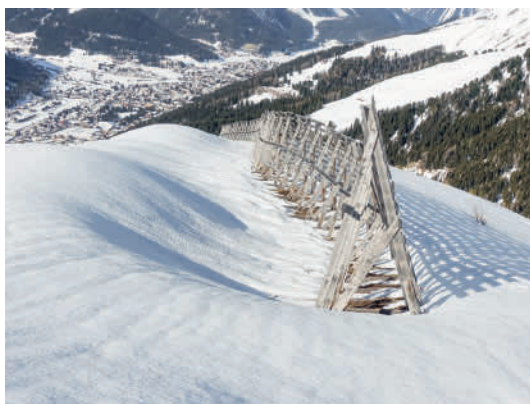
Figur 59 Tribschneezaaun aus Holzelementen. Im Lee des Zaunes (links im Bild) hat sich eine grosse Schneeablagerung gebildet.
