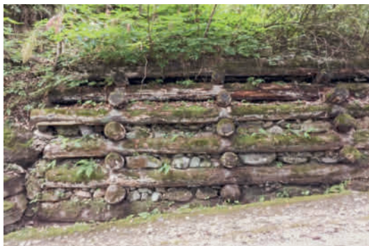
Figur 27 Beispiel eines ungefähr 30-jährigen Holzkastens mit Füllung aus Steinen, verwendet zur Stabili- sierung einer Strassen- böschung.
