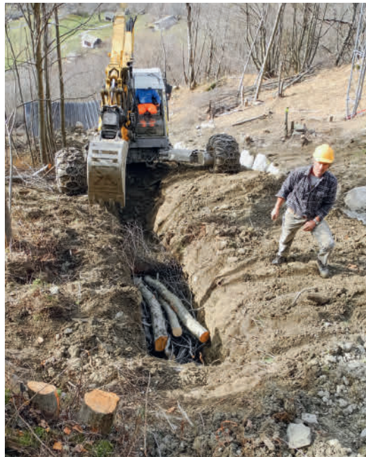
Figur 15 (rechts) Fertiggestellte Drainierung mit Totholzfaschinen.
