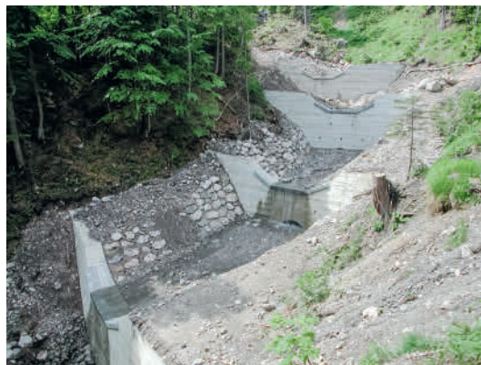
Figur 61 (links) Betonquerbauwerke am Mauerbodenbach aus den Jahren 2006/2007 [65].
