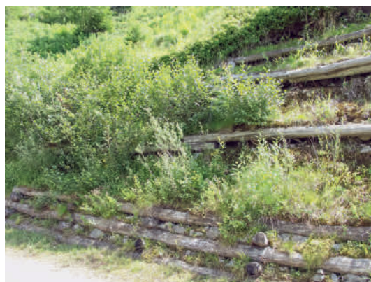
Figur 69 (links) und Figur 70 (rechts) Holzkästen zur Stabilisierung von Hängen mit Vegetation, welche sich gut in das Landschaftsbild einfügen.
