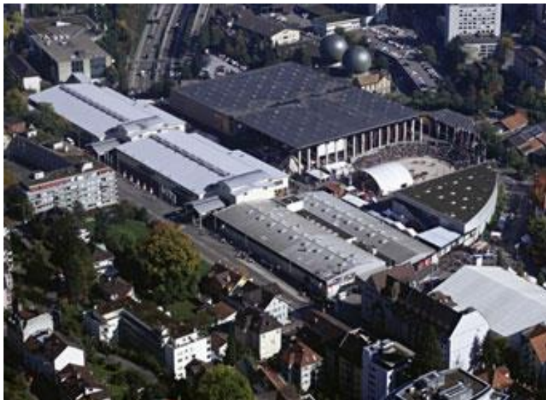
Illustration 9 : vue aérienne de l'objet étudié (halle en deux parties avec toit sombre sur la moitié supérieure de l'image).
