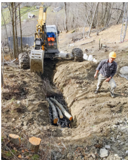
Immagine 14 (a sinistra) Costruzione di un drenaggio con fascine di legno morto.
