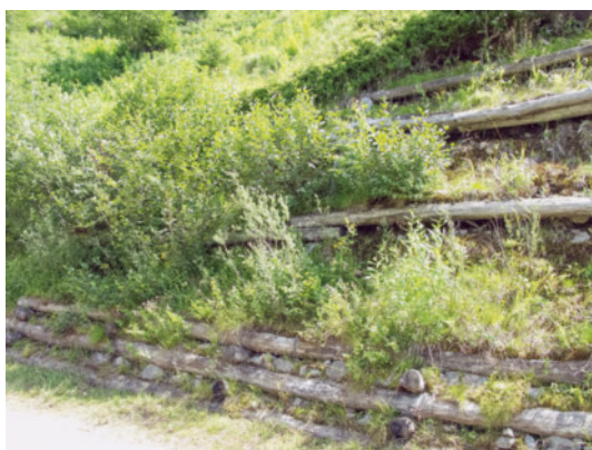
Immagine 69 (a sinistra) e immagine 70 (a destra) Palificate con vegetazione per la stabilizzazione di scarpate, ben integrate nel paesaggio.
