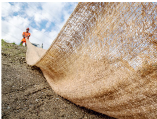
Immagine 8 Protezione contro l'erosione mediante stuoie in lana di legno per il consolidamento di scarpate.
