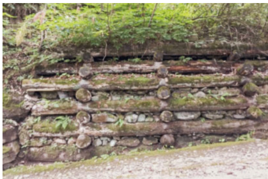
Immagine 27 Esempio di palificata in legno di ca. 30 anni con riempimento di sassi, utilizzata per stabilizzare una scarpata lungo una strada.
