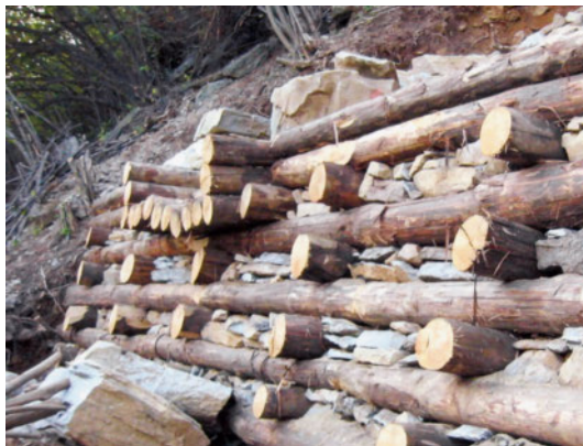
Immagine 25 (a sinistra) Riempimento con sassi facciavista.
