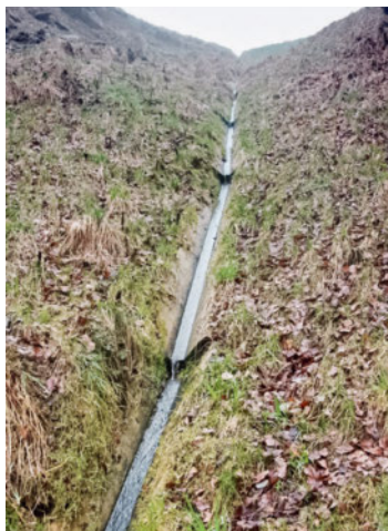
Immagine 13 (a destra) Canaletta a sezione rettangolare con travatura in legno.
