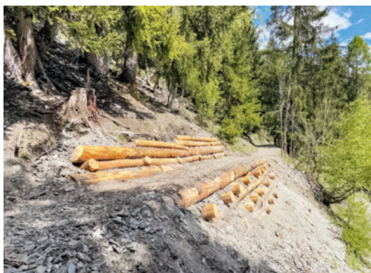
Immagine 28 Stabilizzazione del pendio di una strada forestale.
