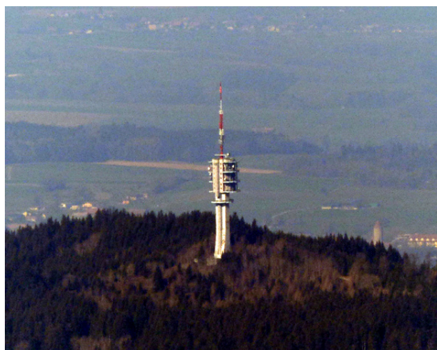
Abb. 66. Kuppenlage + Turm = doppeltes Blitzschlagrisiko: Links der Sendeturm Le Gubloux FR (1205 m), rechts die Kirche Wahlern BE (836 m). Für diese vermeldet die lokale Chronik über die letzten sechs Jahrhunderte nicht weniger als acht Blitzeinschläge mit Schadenfolge.
