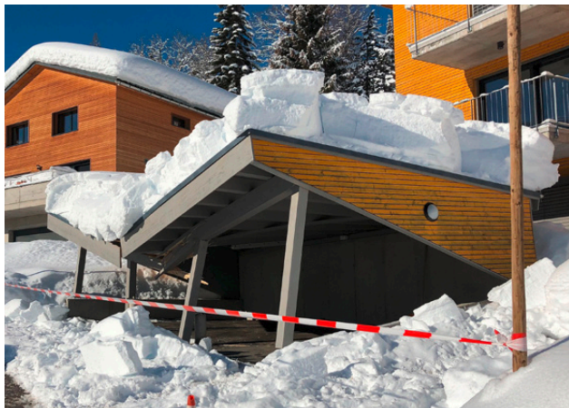
Abb. 27: Links: die Last des aufliegenden Schnees (Schneedruck) hat die Dachkonstruktion des Autounterstandes eingedrückt; rechts: der abrutschende Schnee (Dachlawine) hat Teile des Dachs und der Fotovoltaikanlage beschädigt (Fotos: GVG).
