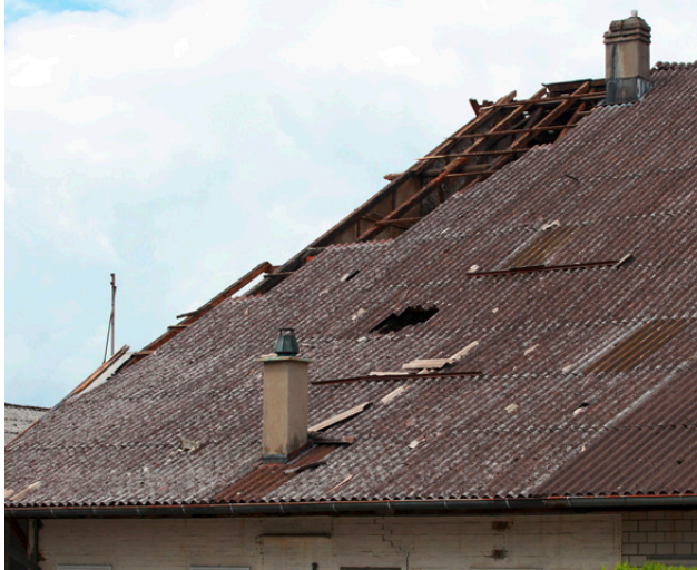
Abb. 10. Links Sturmschaden an Hausdach; rechts vom Sturm gefällte Weisstanne; umstürzende Bäume führen in überbautem Gebiet häufig zu indirekten Sturmschäden an Gebäuden (Foto links: M. Pfeuti).
