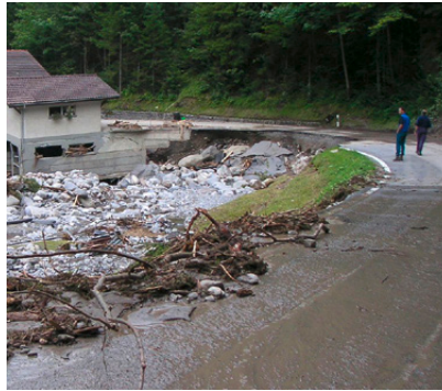
Abb. 18. Links: grossflächige statische Überflutung; Mitte: durch Ufererosion beschädigte Gebäude und Strasse; rechts: Murgangablagerung (Fotos Mitte und rechts: geo7 AG).
