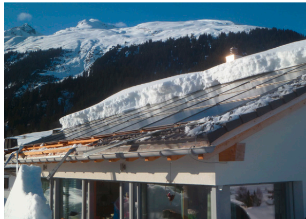
Abb. 27: Links: die Last des aufliegenden Schnees (Schneedruck) hat die Dachkonstruktion des Autounterstandes eingedrückt; rechts: der abrutschende Schnee (Dachlawine) hat Teile des Dachs und der Fotovoltaikanlage beschädigt (Fotos: GVG).
