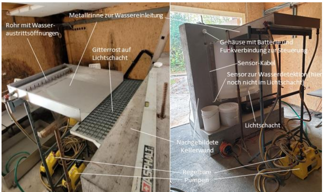
Abbildung 5. Realisierte Versuchsanlage mit Komponenten auf Aussenseite der nachgebildeten Kellerwand. Blick von oben (links), Blick auf Aussenwand (rechts).
