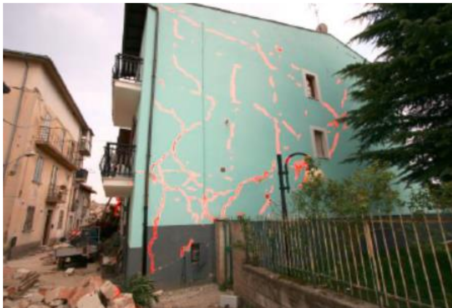
Abbildung 8-6 SwissInspect: Rissdetektion mittels Deep Learning, mit freundlicher Genehmigung von SwissInspect [31].
