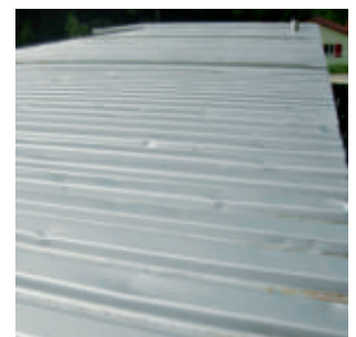
Fig. 64: à gauche, appareil défectueux: la coupole en plexiglas et la sensorique des capteurs de luminosité sont endommagées, l'appareil n'est plus en état de fonctionner. A droite, dommage esthétique: le toit de tôles trapézoïdales présente des bosses bien visibles; il n'est cependant pas atteint dans sa fonction de protection contre les intempéries (photos: ECA TG).
