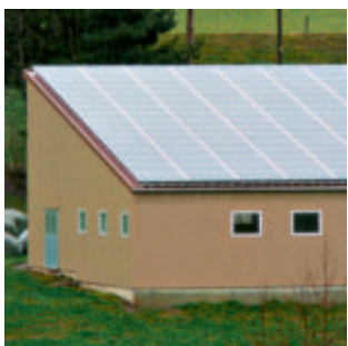
Installation d'énergie solaire
