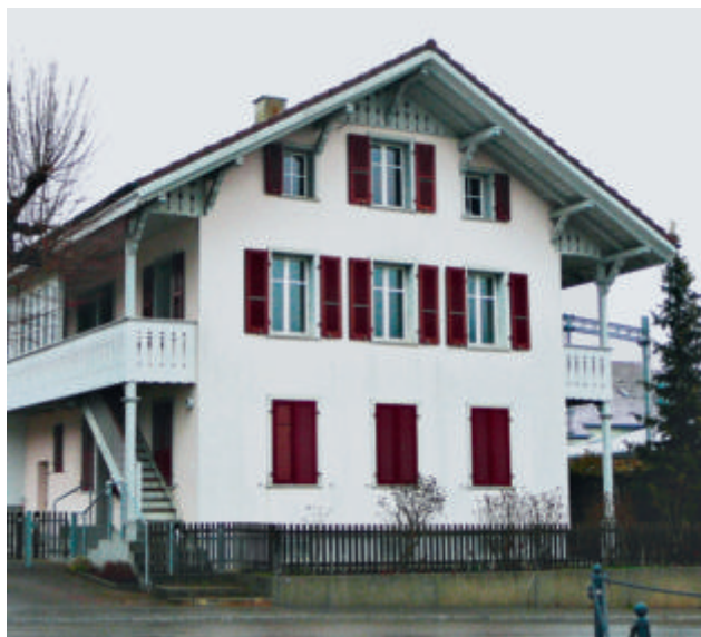
Fig. 33: mode de construction ancien – maison d'habitation (année de construction 1904) et bâtiment industriel (année de construction 1917). L'enveloppe du bâtiment est constituée surtout de matériaux relativement résistants à la grêle tels que la tuile (toits), le crépi sur maçonnerie (façade) et le bois massif (volets, annexes en façade, portes). Les pans débordants de la toiture protègent assez efficacement la façade contre les chutes de grêle (photos: UIR).
