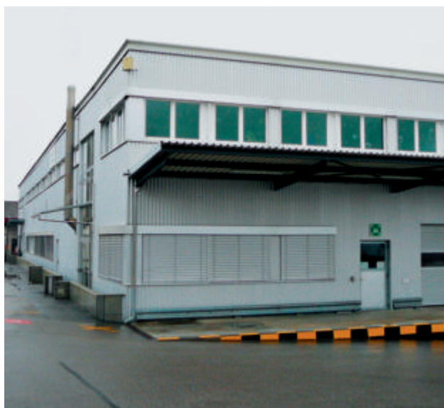
Fig. 34: mode de construction moderne – maison d'habitation (année de construction 1999) et bâtiment industriel (année de construction 1972, transformation/nouveau revêtement de façade 2002/03). L'enveloppe du bâtiment est constituée de matériaux relativement sensibles à la grêle tels que la tôle (façade, stores à lamelles, revêtements, annexes en façade), le ciment fibreux (toiture), la matière synthétique (avant-toits) et des surfaces en bois peintes (façade). Les pans du toit ne protègent pas ou à peine contre la grêle (photos: UIR).
