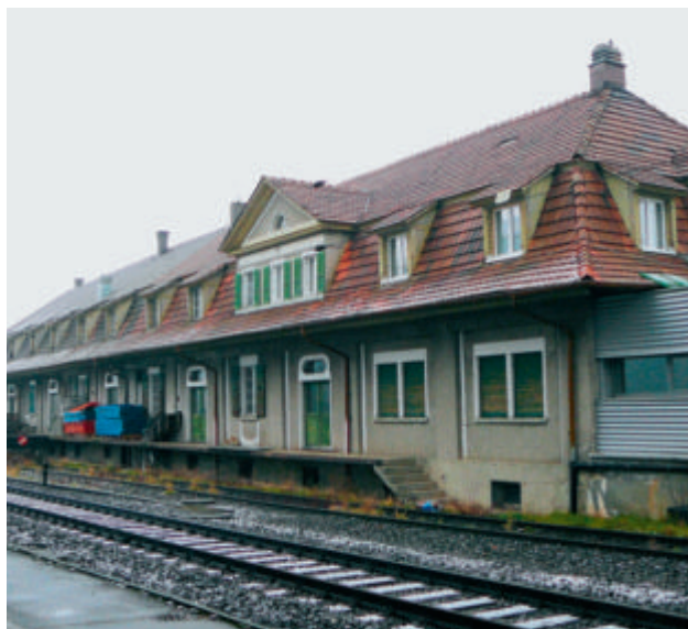
Fig. 33: mode de construction ancien – maison d'habitation (année de construction 1904) et bâtiment industriel (année de construction 1917). L'enveloppe du bâtiment est constituée surtout de matériaux relativement résistants à la grêle tels que la tuile (toits), le crépi sur maçonnerie (façade) et le bois massif (volets, annexes en façade, portes). Les pans débordants de la toiture protègent assez efficacement la façade contre les chutes de grêle (photos: UIR).
