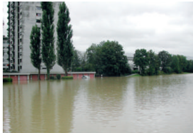
Abb. 11. Durch die Sorne grossflächig überschwemmtes Siedlungsgebiet in Delsberg an der Rue du Haut-Fourneau ... (Foto: ECA Jura).
