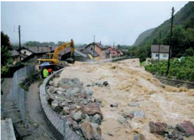
Abb. 17. Ausbruchstelle der stark geschiebepfrachteten Eau Froide oberhalb des Dorfes Roche (Foto: SSCM).
