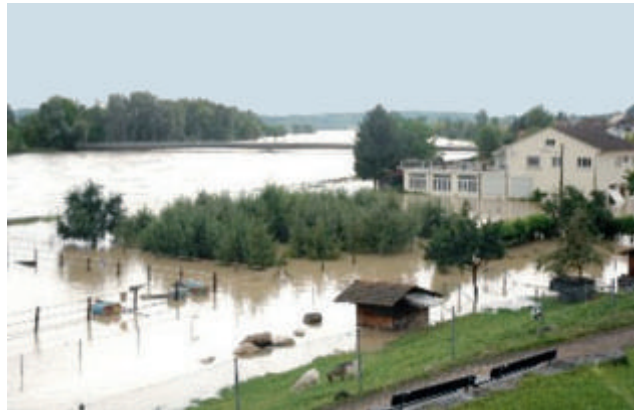
Abb. 5. Überflutung durch die Aare in Döttingen (Austrasse) (Foto: Feuerwehr Döttingen-Klingnau).
