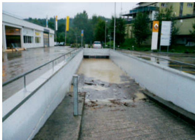
Abb. 14. Geflutete Tiefgarage im Gebiet Reusszopf am rechten Ufer der Kleinen Emme in Reussbühl (Gemeinde Littau) (Foto: GVL).
