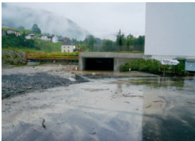
Abb. 13. Grossflächige Überschwemmung und geflutete Tiefgarage durch die Kleine Emme in der Niedermatt in Littau (Foto: GVL).
