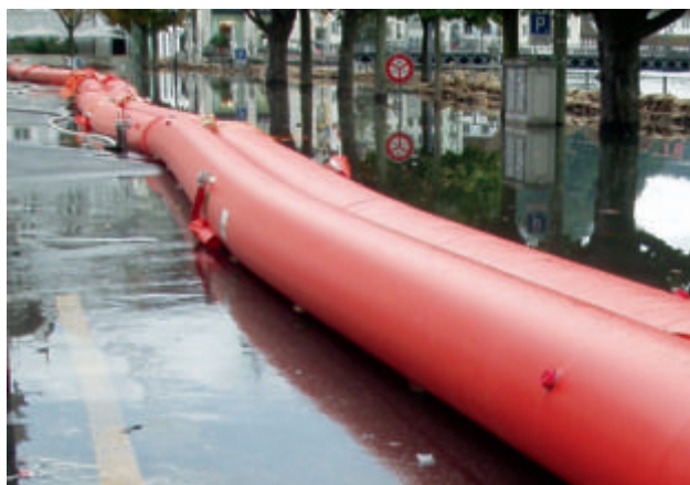
Abb. 27. Mobiles Hochwasserschutz-System im Einsatz (Foto: T. Egli).
