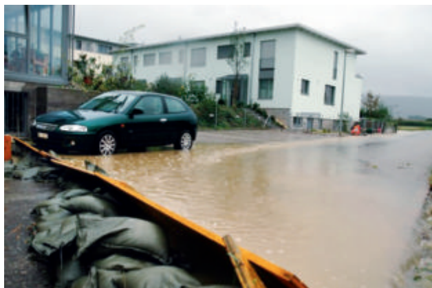
Abb. 28. Mobile Objektschutzmassnahmen, bestehend aus Sandsäcken und Schaltafeln in Therwil (Grossmattweg) (Foto: Feuerwehr Therwil).
