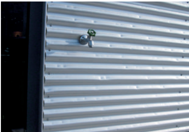
Abbildung 6.7: Fassadenblech, Foto AVA.
