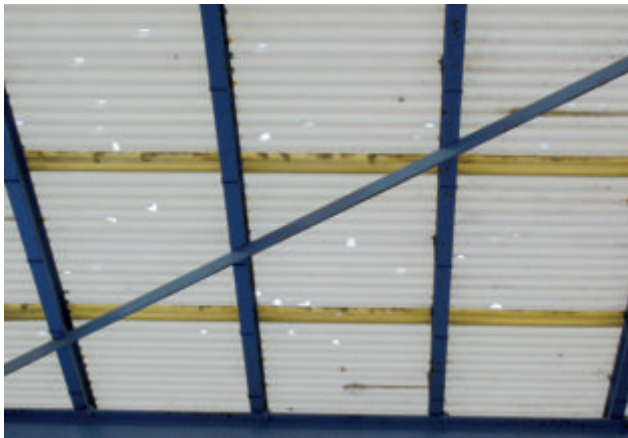
Abbildung 6.17: Kunststoffplatte Dach, Foto GVZ .
