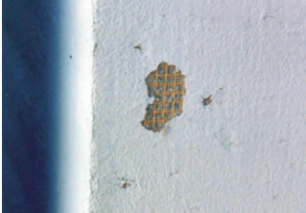
Abbildung 6.11: armierter Putz auf Aussenwärmedämmung, Foto GVL.
