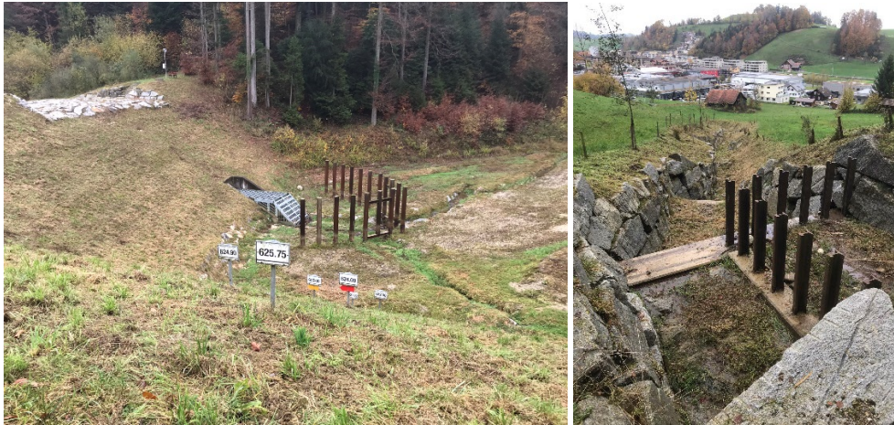
Abbildung 25a/b: Beispiele von Flächenschutzmassnahmen: Rückhaltebecken Rickenbach (links), Geschiebesammler am Rüdélgraben (rechts)
