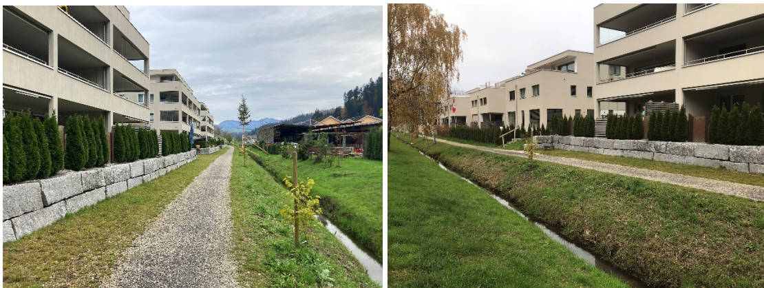
Abbildung 26a/b: Objektschutzmassnahmen entlang der Seewag
