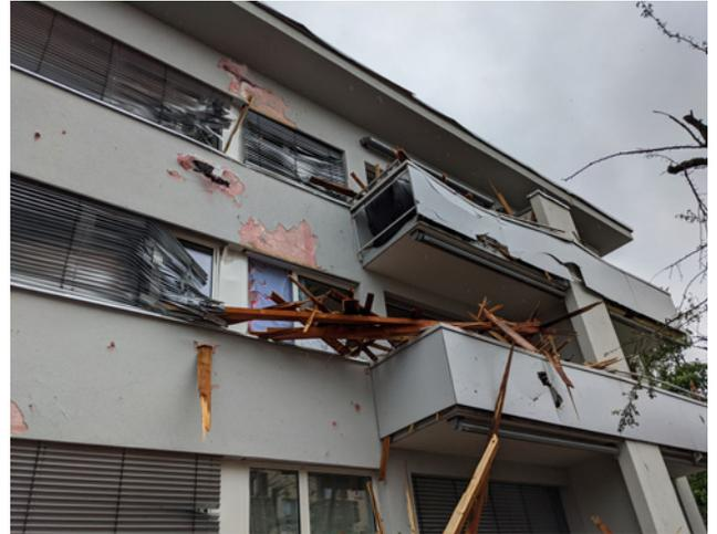
Illustration 15 : Bâtiment d'habitation à Zurich-Altstetten dont les stores à lamelles ont été déchirés, les fenêtres brisées et les façades lourdement endommagées par des morceaux de bois arrachés du toit d'un bâtiment voisin (photo : GVZ).
