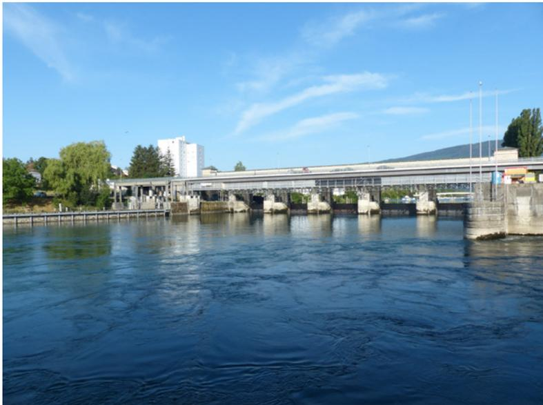
*Illustration 20: Le barrage de régulation de Port (BE) sur le canal de Nidau-Büren, avec ses cinq vannes. Photo prise le 7 juillet 2023 en période d'étiage (196 m<sup>3</sup>/s) ; vue vers l'amont (photo : UIR).*
