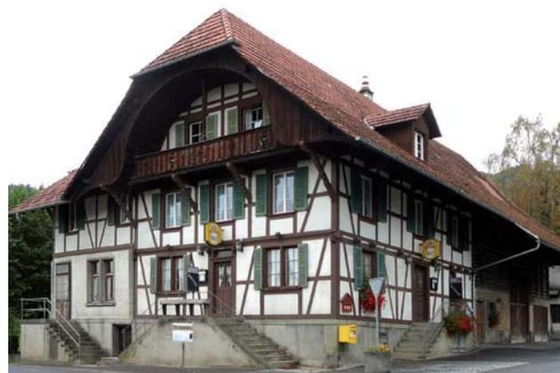
**III. 17 :** auberge de village typique, de construction « traditionnelle » : colombages crépis sous un large toit de tuiles et volets en bois. Ce genre de construction est comparativement plus résistant à la grêle (photo : C. Oesch).
