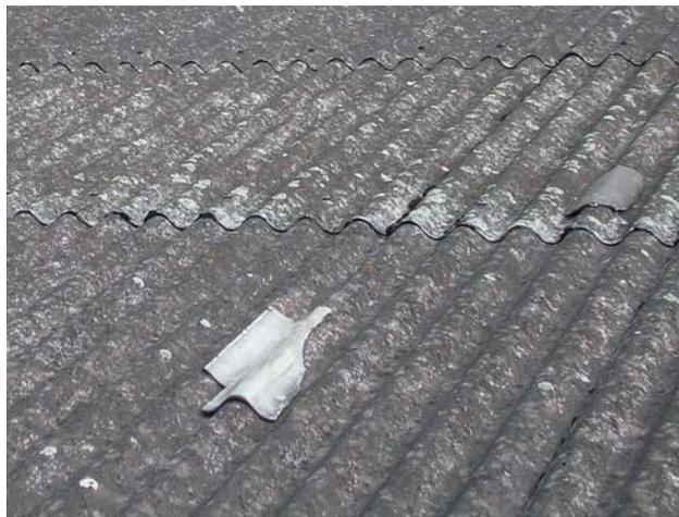
**III. 21:** *Dompage grêle typique sur un toit en eternit ondulé : les grêlons ont provoqué des éclatements et des fissures (non visibles sur la photo) (photo : ECA d'Argovie).*
