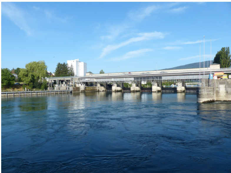
Abb. 20: Das Regulierwerk Port BE im Nidau-Büren-Kanal mit seinen fünf Schützen am 7. Juli 2023 bei Niedrigwasser (196 m³/s); Blick stromaufwärts (Foto: IRV).
