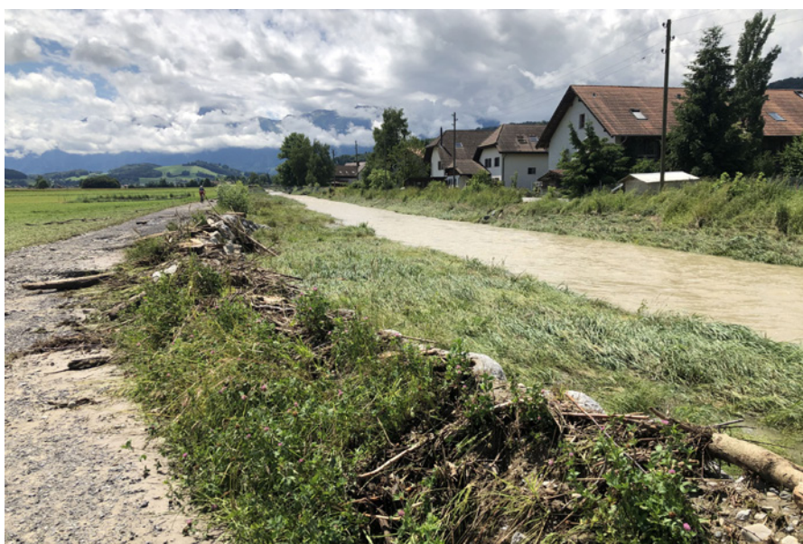
Abb. 28a, b: Die Massnahme funktioniert! Der 2019 erhöhte, vor den Gebäuden verlaufende Damm soll die Uferanstösser von Mühlethurnen BE vor Hochwas- sern der Gürbe schützen und das Wasser stattdessen ins jenseitige Landwirtschaftsland entlasten (Bild 28a). Am 21. Juni 2021 hat dies funktioniert: Das 30- bis 50-jährliche Hochwasser verur- sachte keine Schäden im Sied- lungsgebiet. Bild 28b zeigt die Spuren des Hochwassers am Folgetag; Blick flussaufwärts (Fotos: IRV).
