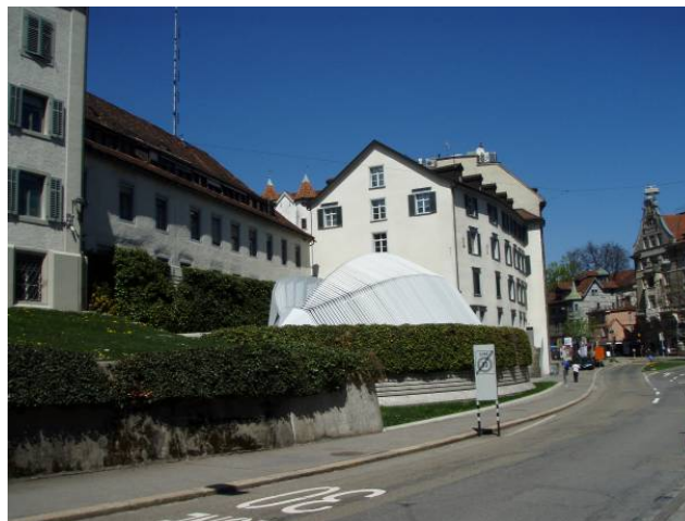
Abbildung 6: Die Moosbruggstrasse mit der muschelförmigen KNZ (Mitte), links das alte Gebäude Klosterhof 12 (Quelle: Egli Engineering AG).
