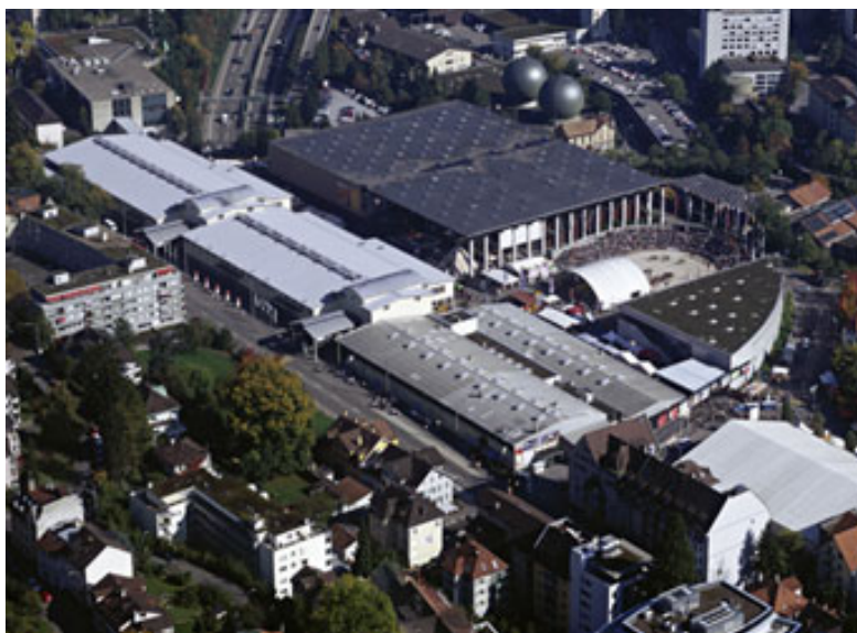
Abbildung 9: Luftansicht des untersuchten Objektes (2-teilige Halle mit dunklem Dach in der oberen Hälfte des Bildes).
