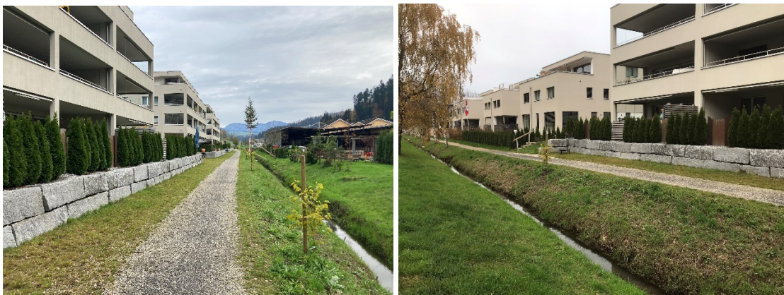
Abbildung 26a/b: Objektschutzmassnahmen entlang der Seewag
