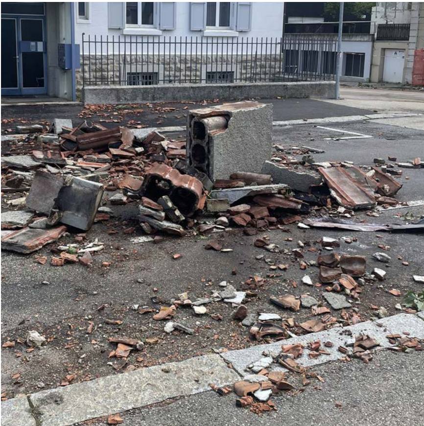
Abb. 32: Auf die Strasse geworfener Kamin: Das Bild verdeutlicht die tödliche Gefahr, der die Bevölkerung in La Chaux-de-Fonds während des Sturmes ausgesetzt war. (Quelle: ECAP NE)
