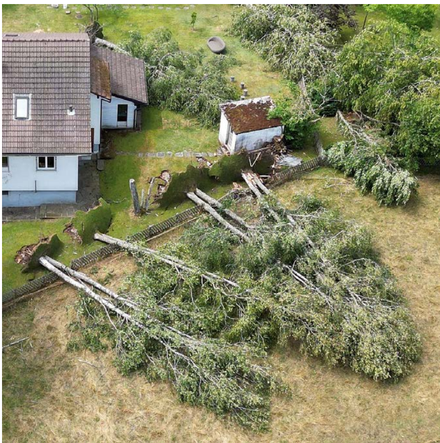
Illustration 67 : Plusieurs arbres ont été renversés, y compris leurs assiettes racinaires organisées de manière très horizontale (sans doute principalement des hêtres rouges). Par chance, ils ont tous chuté dans la direction opposée aux bâtiments tout proches. (source : ECAP)
