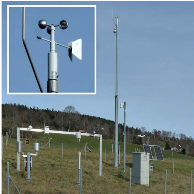
Illustration 9 : La station de mesure MétéoSuisse de La Chaux-de-Fonds, aux Éplatures, avec son anémomètre à coupelles avec girouette à double lame, de la marque Lambrecht, type 14512, monté sur un mât de 10 mètres. (photo : UIR)
