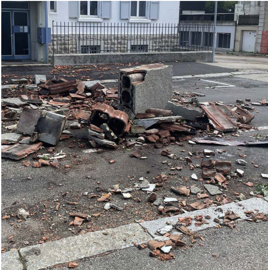
Illustration 32 : Cheminée projetée dans la rue : cette image met en lumière le danger de mort qui menaçait la population de La Chaux-de-Fonds pendant la tempête. (source : ECAP)
