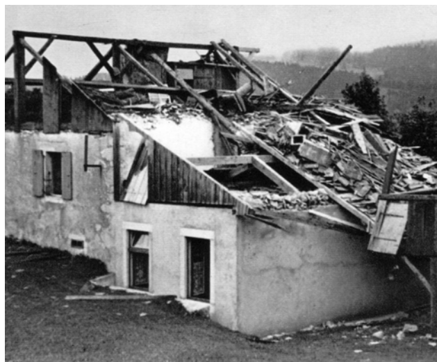
Illustration 64 : Sur les bâtiments d'un établissement de restauration situé à l'ouest de La Chaux-de-Fonds, les surfaces de toiture ainsi que des éléments de façade en bois ont été arrachés. (photo : F. Haefeli, La Chaux-de-Fonds)
