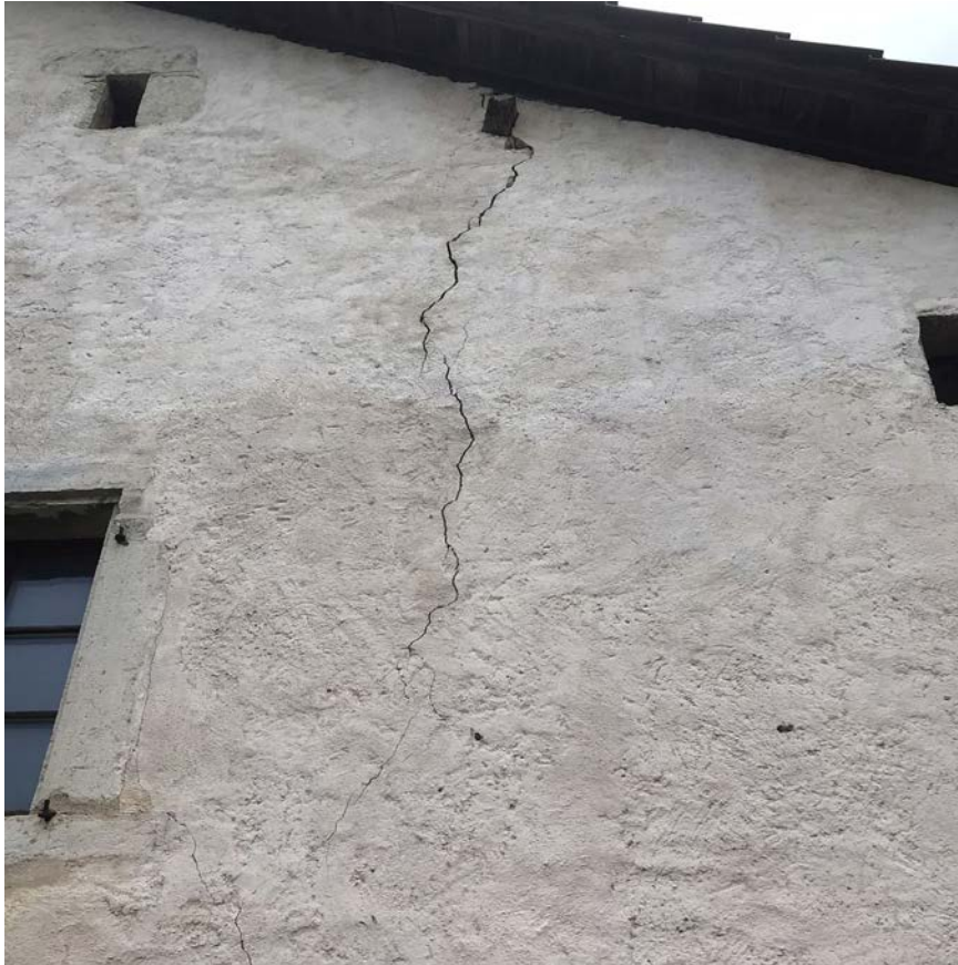
Illustration 50 : Sur un bâtiment d'habitation construit en 1902, un mur en maçonnerie est marqué de fissures. La fissure principale part d'une panne. Conformément à la description des dommages, une partie importante du toit a été endommagée. On peut dès lors supposer que la fissure a été causée par un effet de levier exercé par la poutre sur la maçonnerie, et non par la charge directe du vent sur la maçonnerie. Cela s'accorde avec le fait que la maçonnerie présente une résistance particulièrement faible à la traction transversale. (source : ECAP)
