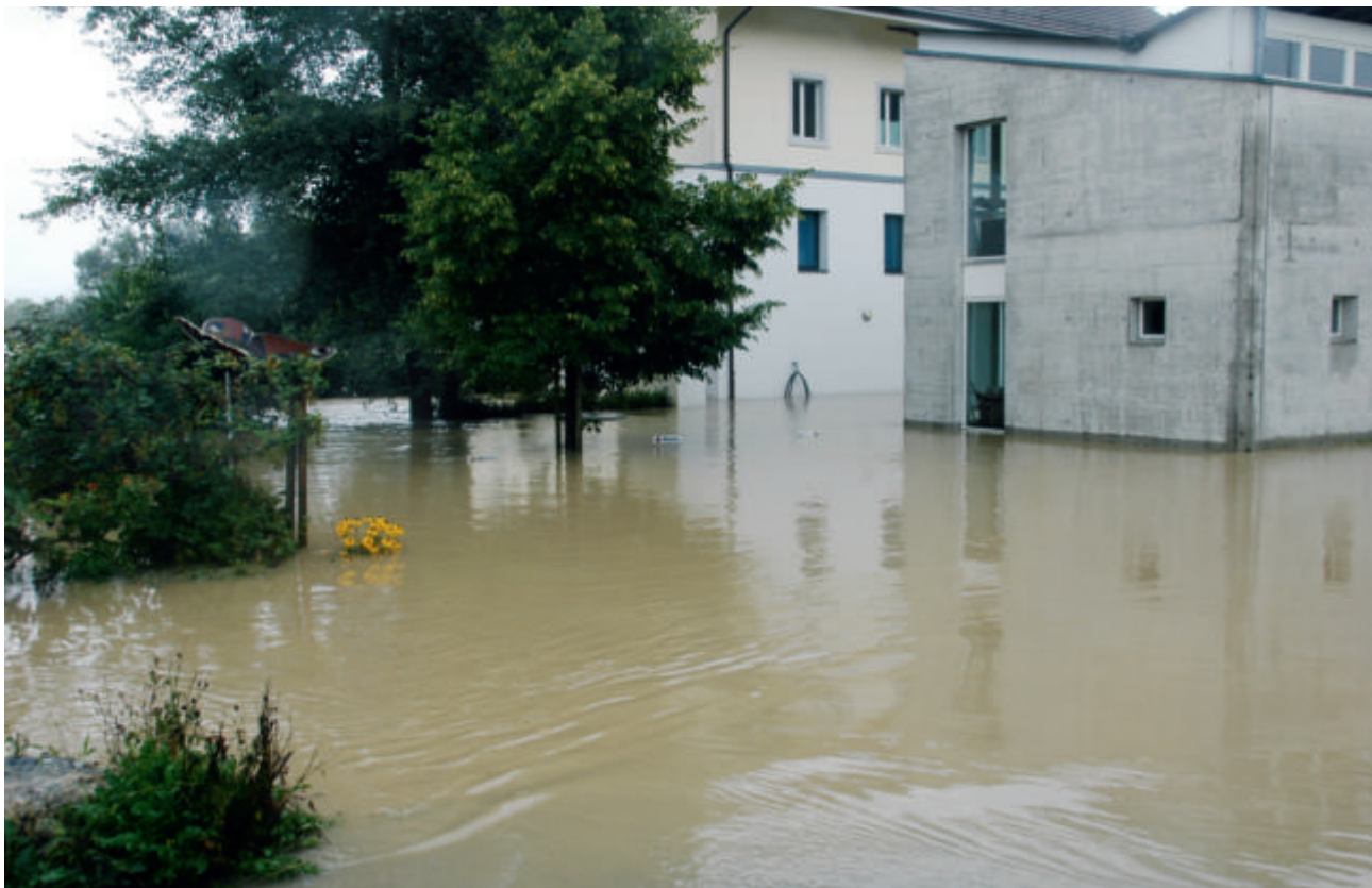
Figure 6: moulin à plâtre inondé à Lauffohr (photo: corps de sapeurs-pompiers de Brugg).
