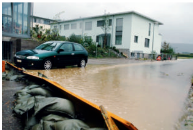
Figure 28: mesure mobile de protection d'objet réalisée avec des sacs de sable et des panneaux de coffrage, à Therwil (Grossmattweg)
