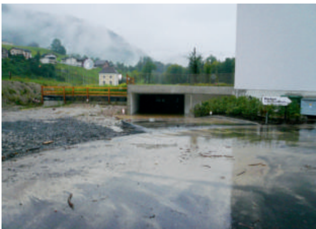
Figure 13: inondation et garage souterrain noyé par la Petite Emme au lieu-dit Niedermatt, à Littau (photo: GVL).
