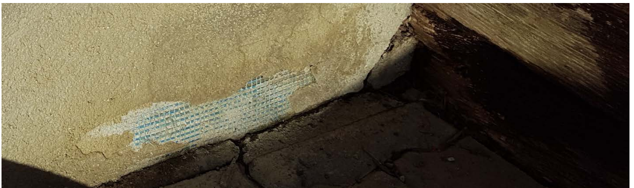
Bild 32: Abplatzung der Deckschicht durch mechanische Beschädigung (vermutlich durch Schläge von Schneeschuhen oder einer Schneeschaufel) kombiniert mit Frost-Tau-Zyklen, Beispiel an einem Gebäude in Grindelwald.
