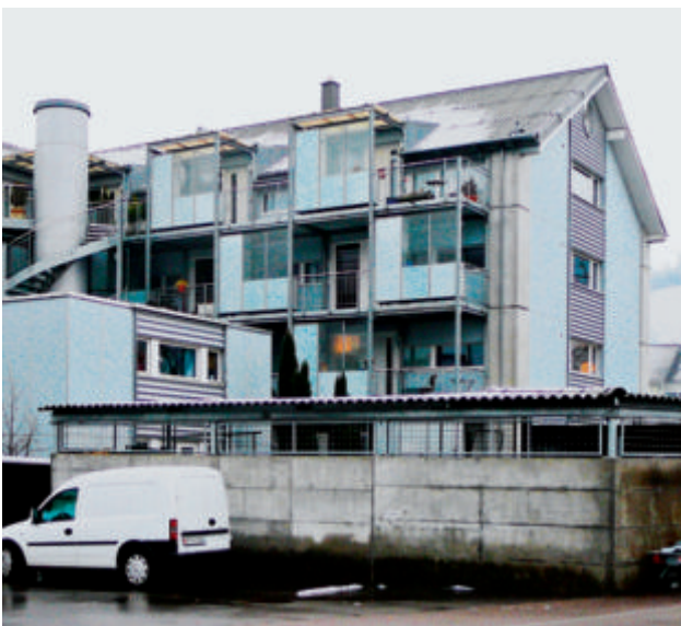
Abb. 34: Moderne Bauweise: Wohnhaus (Baujahr 1999) und Industriegebäude (Baujahr 1972, Umbau / neue Fassadenverkleidung 2002/03). Die Gebäudehülle besteht aus relativ hagelempfindlichen Materialien wie Blech (Fassade, Raffstoren, Verkleidungen, Fassadenanbauten), Faserzement (Dachfläche), Kunststoff (Vordächer) und gestrichenen Holzflächen (Fassade). Die Dachflächen schützen die Fassaden kaum oder gar nicht vor Hagel (Fotos: IRV).
