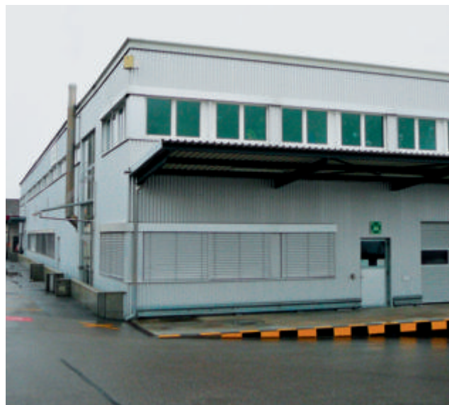
Abb. 34: Moderne Bauweise: Wohnhaus (Baujahr 1999) und Industriegebäude (Baujahr 1972, Umbau / neue Fassadenverkleidung 2002/03). Die Gebäudehülle besteht aus relativ hagelempfindlichen Materialien wie Blech (Fassade, Raffstoren, Verkleidungen, Fassadenanbauten), Faserzement (Dachfläche), Kunststoff (Vordächer) und gestrichenen Holzflächen (Fassade). Die Dachflächen schützen die Fassaden kaum oder gar nicht vor Hagel (Fotos: IRV).
