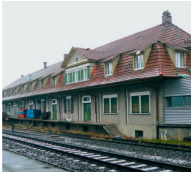
Abb. 33: Ältere Bauweise: Wohnhaus (Baujahr 1904) und Fabrikgebäude (Baujahr 1917). Die Gebäudehülle besteht v.a. aus relativ hagelresistenten Materialien wie Ziegel (Dächer), Verputz auf Mauerwerk (Fassade) und Massivholz (Fensterläden, Fassadenanbauten, Türen). Die ausladenden Dachflächen schützen die Fassaden recht wirkungsvoll vor Hagelschlag (Fotos: IRV).
