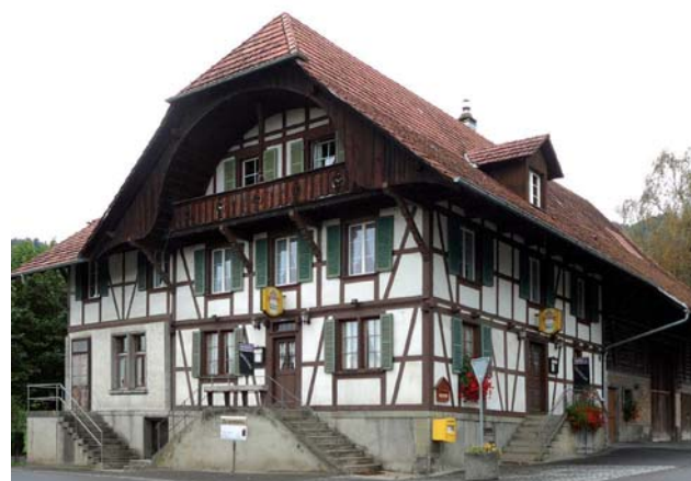
Abb. 17: Typischer Dorfgasthof in «traditioneller» Bauweise: verputzter Fachwerkbau unter ausladendem Ziegeldach, versehen mit hölzernen Fensterläden – Gebäude in dieser Bauweise sind verhältnismässig hagelresistent (Foto: C. Oesch).
